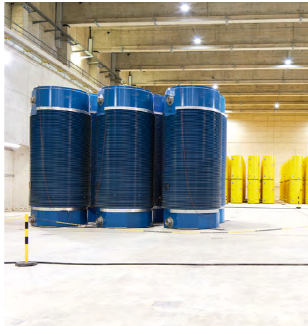
Blick auf CASTOR-Behälter im östlichen Hallenteil des Zwischenlagers Ahaus
