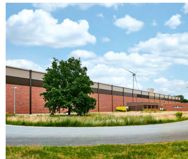
Außenansicht des Zwischenlagers Ahaus mit neu errichteter Schutzwand
